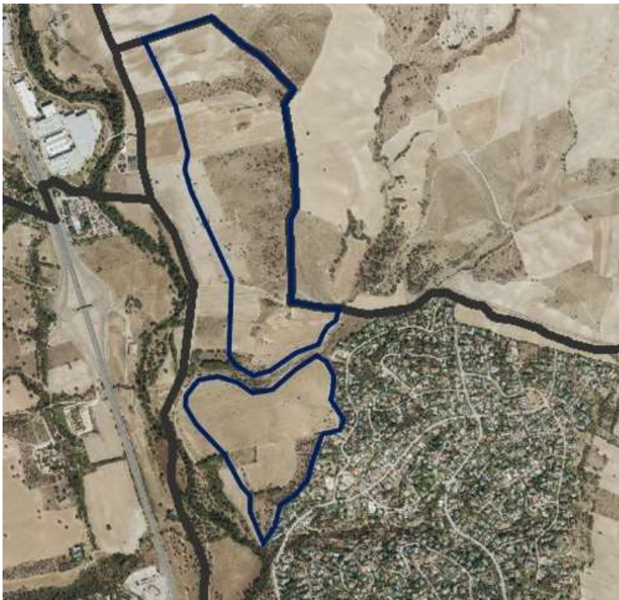
Fotografía aérea del ámbito y su entorno del año 2022. En negro límite del Plan. Fte. Nomecalles (Comunidad de Madrid).
